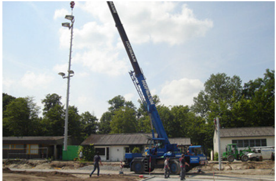
Ein Kran hebt einen der Flutlichtmasten an seine endgültige Position. Bild: Ingenieurbüro Rößler
