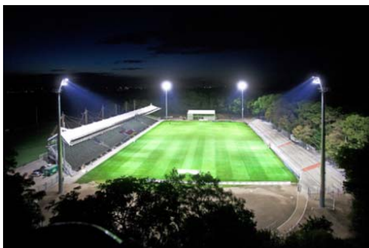
Die neue Flutlichtanlage im Stadion Höhenberg wurde an die Anforderungen der Regionalliga angepasst
