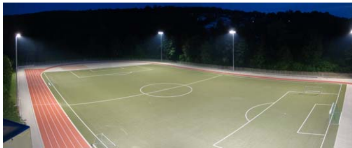
Das neue Flutlicht in Bielefeld. Bild: INGENIEURBÜRO RÖBLER
